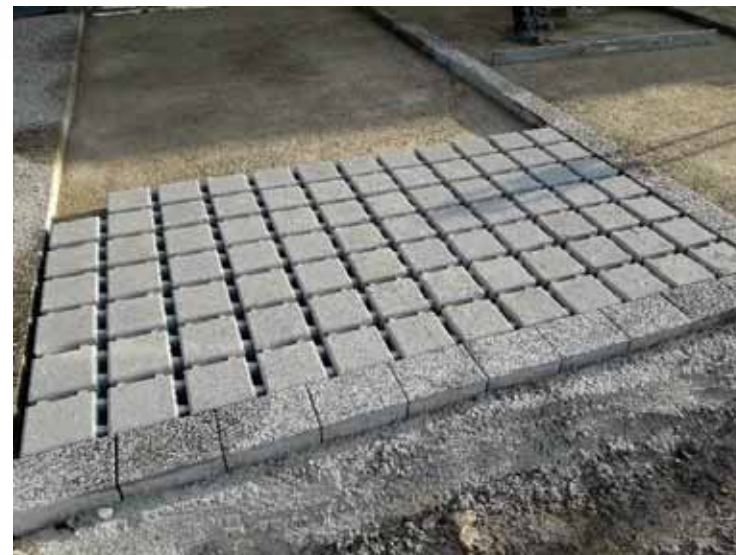
Pose des pavés drainants sur sable 0/4
