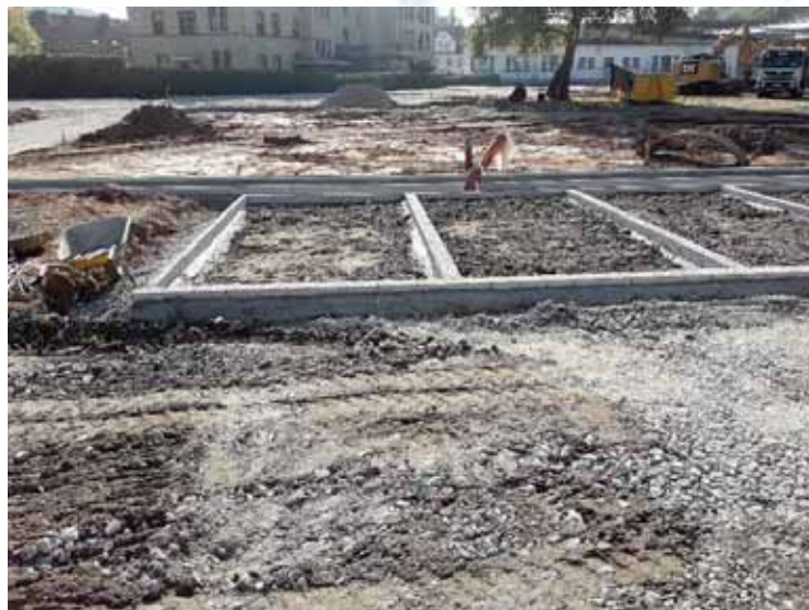
Préparation voirie - parking empiérement recyclé 0/60
