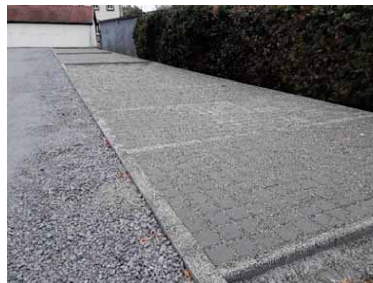
Remplissage des joints au refus en concassé 4/6
